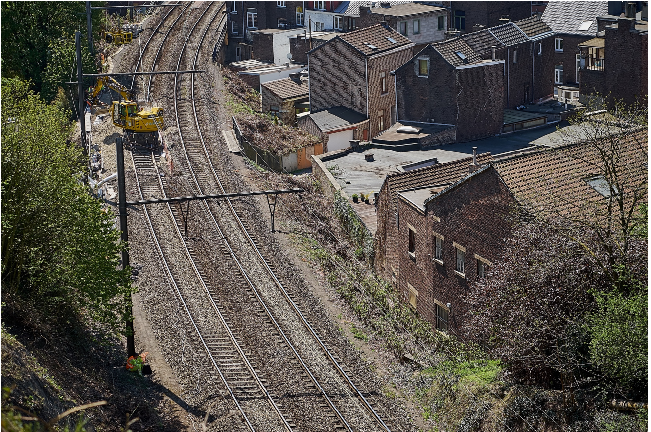
Photo 8: Travaux sur les voies.
