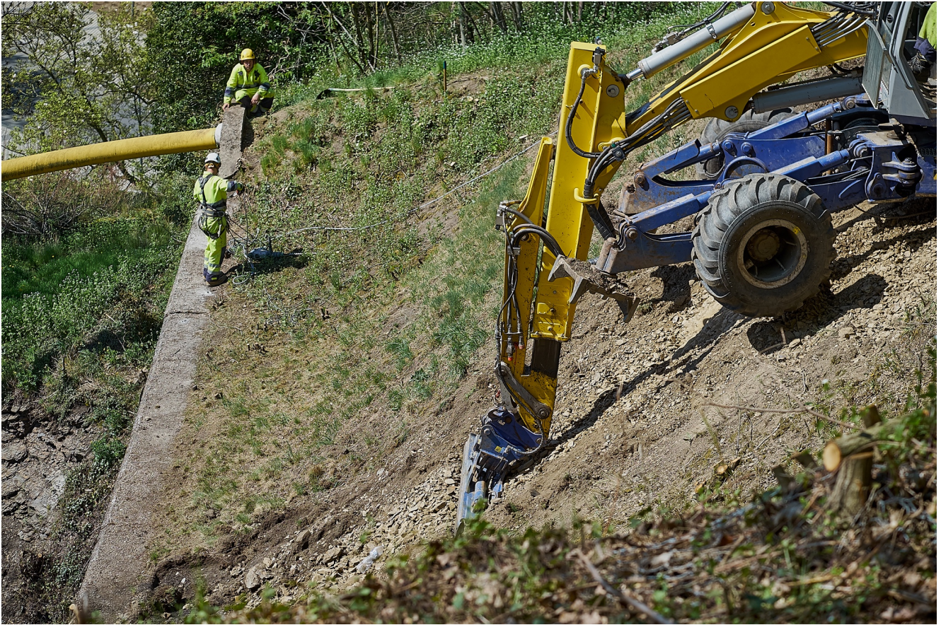
Photo 7: Dégagement des pierres au-dessus du tunnel.
