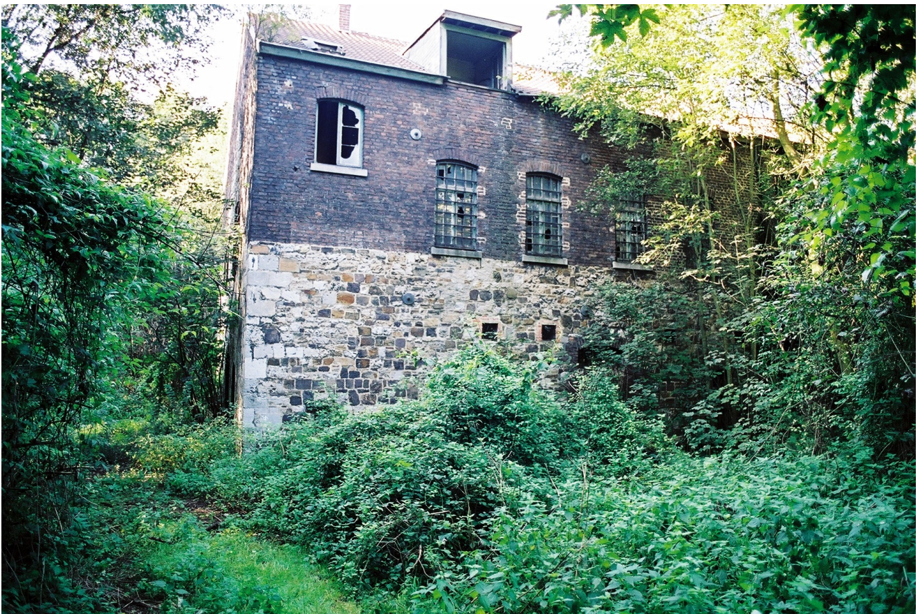
26: BM40 – Hangar à affuts de canons Cliquez pour agrandir
