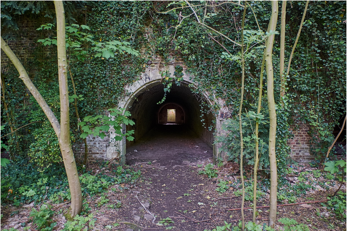
8: Poterne du bastion 2, côté corps de place Cliquez pour agrandir
